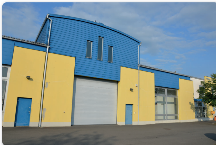
Büro & Lager Fehring
